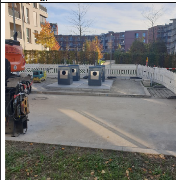
Otto-Meitinger-Straße mit Baustelle für Wertstoffcontainer
