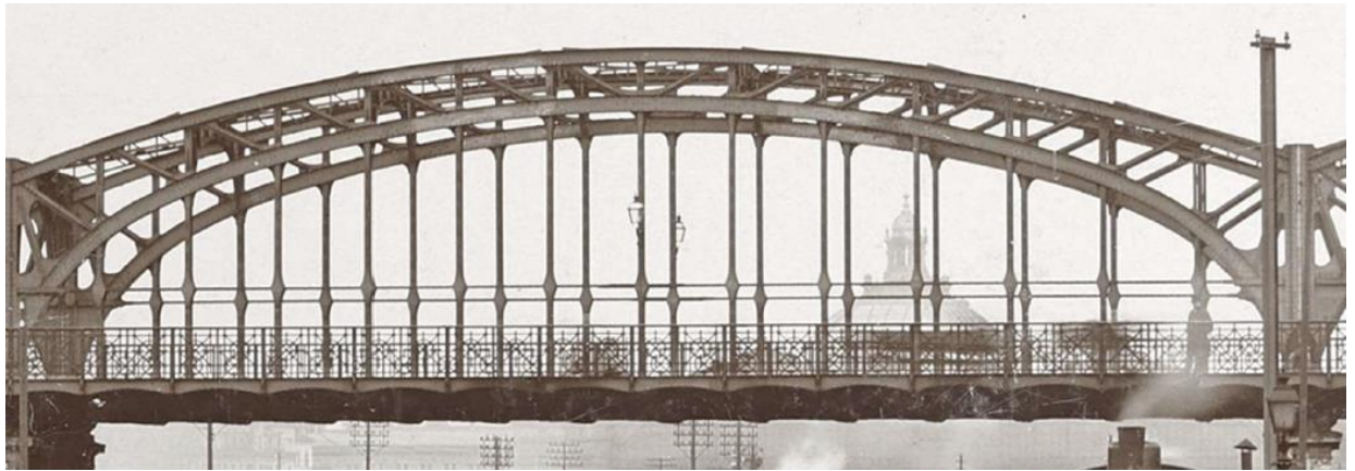
Hackerbrücke, Zustand um 1900, Ansicht von Westen. Quelle: Bildausschnitt Gutachten Dr. Voigts – historische Beleuchtung
