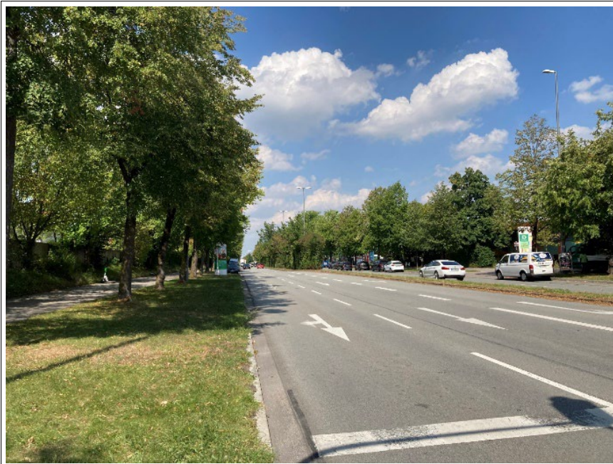
Ingolstädter Straße, Ecke Am Haag; Blickrichtung nach Norden
