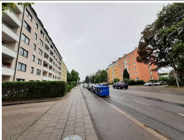
Balanstraße im Bereich Bad-Dürkheimer-Straße, Blickrichtung nach Süden
