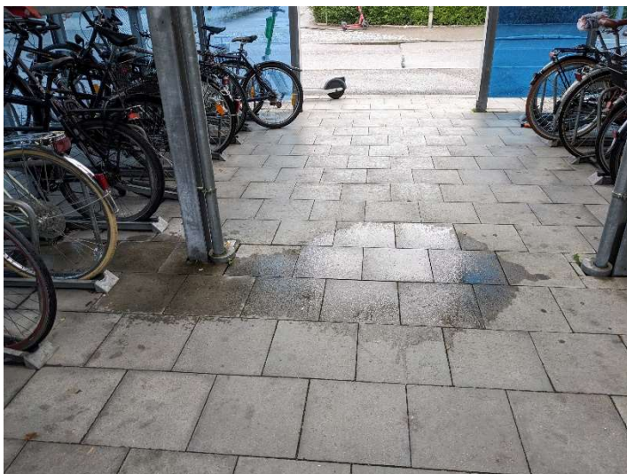
[4] Das B+R-Parkhaus ist undicht (bereits bei geringem Niederschlag)
