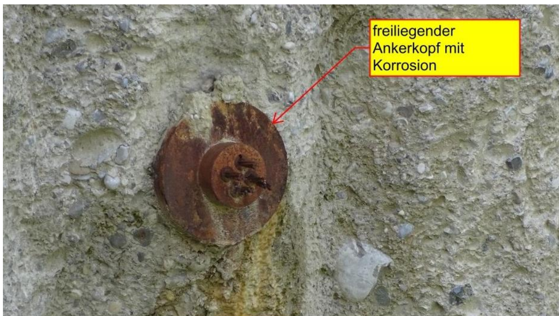
Abbildung 4: freiliegender Ankerkopf – Verpressanker mit 4 Litzen
