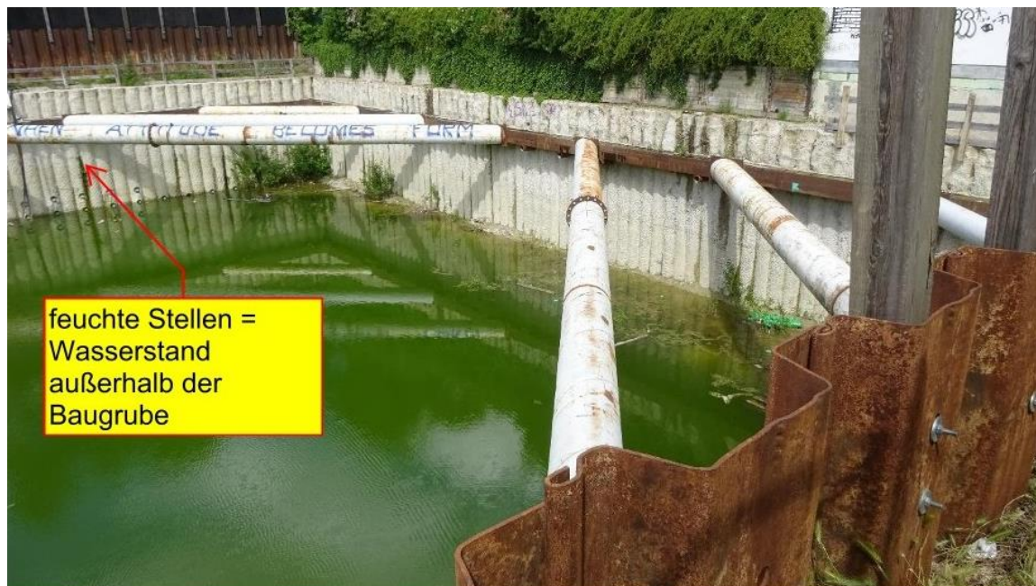
Abbildung 2: Baugrubenaussteifung im Bereich der östlichen Baugrube
