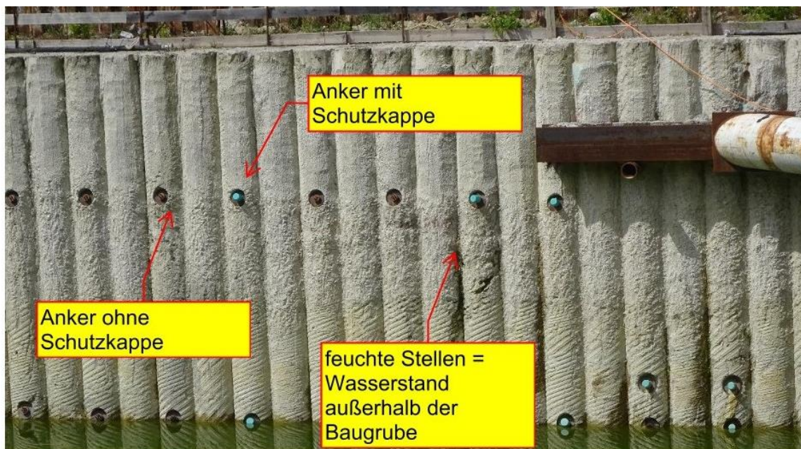
Abbildung 1: Ausschnitt Ansicht nördliche Baugrubenwand
