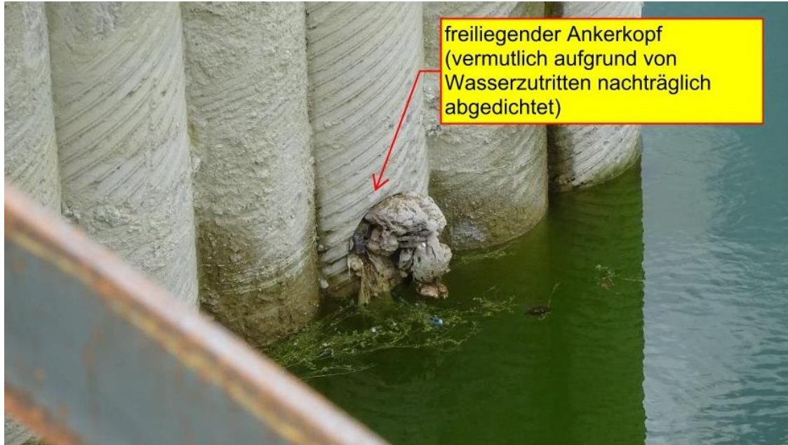
Abbildung 3: freiliegender Ankerkopf
