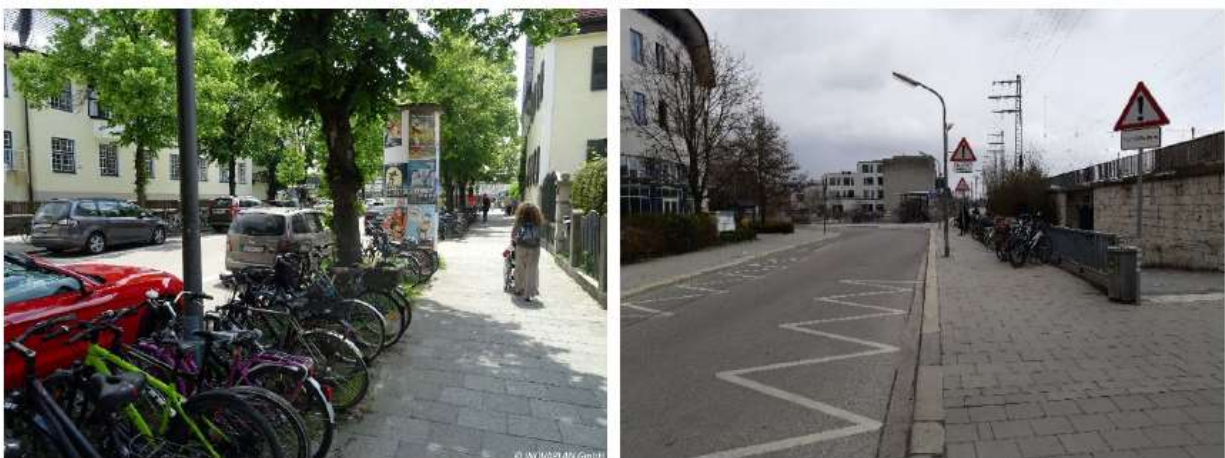
Abbildung 3: Radabstellanlagen August-Exter-Straße / südliche Gottfried-Keller-Straße (Quelle: Inovaplan GmbH)
