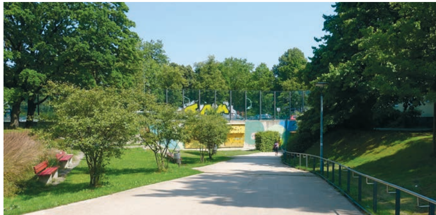
Barrierefreier Eingangsbereich zur Unterführung (Foto: Weeber+Partner)
