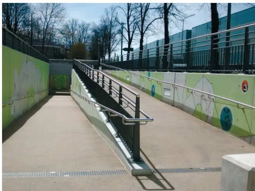
Die neugestaltete Rampe der Unterführung (Foto: Büro für Soziale Stadtentwicklung)
