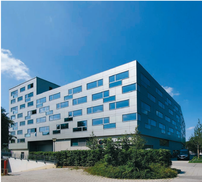
Wohnungen für Auszubildende in der Lärmschutzbebauung am Innsbrucker Ring / Grafinger Straße (Foto: Weeber+Partner)
