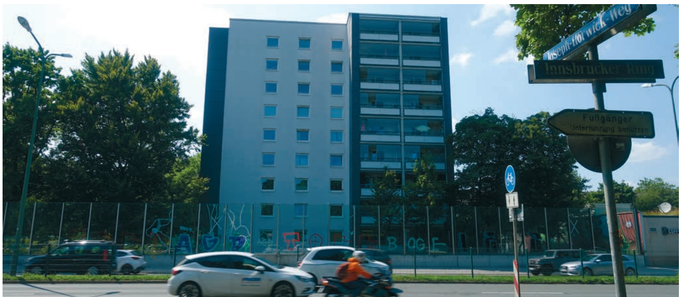
Das sanierte Gebäude der Pertisaustraße vom Innsbrucker Ring aus (Foto: Weeber+Partner)
