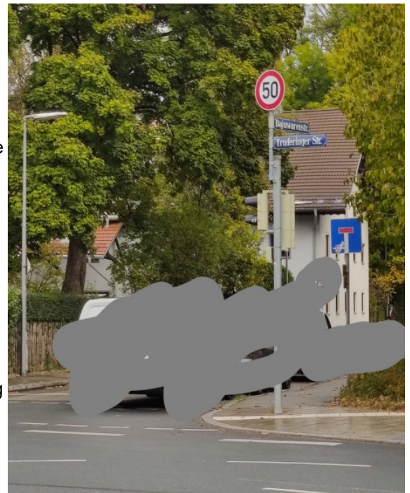
Nördliche Bajuwarenstraße im Kreuzungsbereich Bajuwarenstraße/Truderinger Straße.
