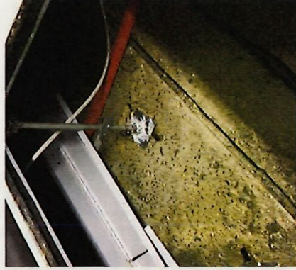
Abb. oben links, WC-Ring: Korrodierte Absperrventile mit Ablagerungen
