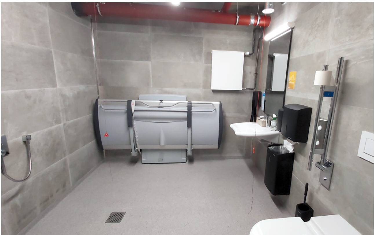
Barrierefreie Toilette in der Kletterhalle Heavens Gate
