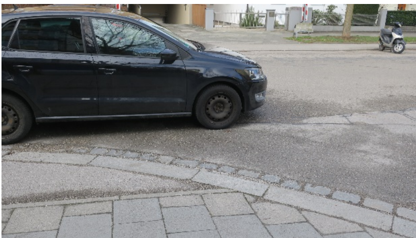
Friedenheimer Straße Ostseite / Einmündung Heinrich-Heine-Straße Südseite
