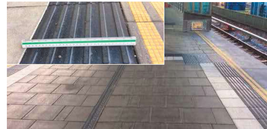
Leitstreifen nach DIN 32984, aktuelle Fassung (Kieferngarten)
