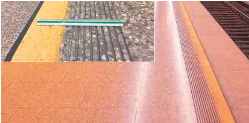
Nachträglich gefräste Rillenbänder (Sendlinger Tor)
