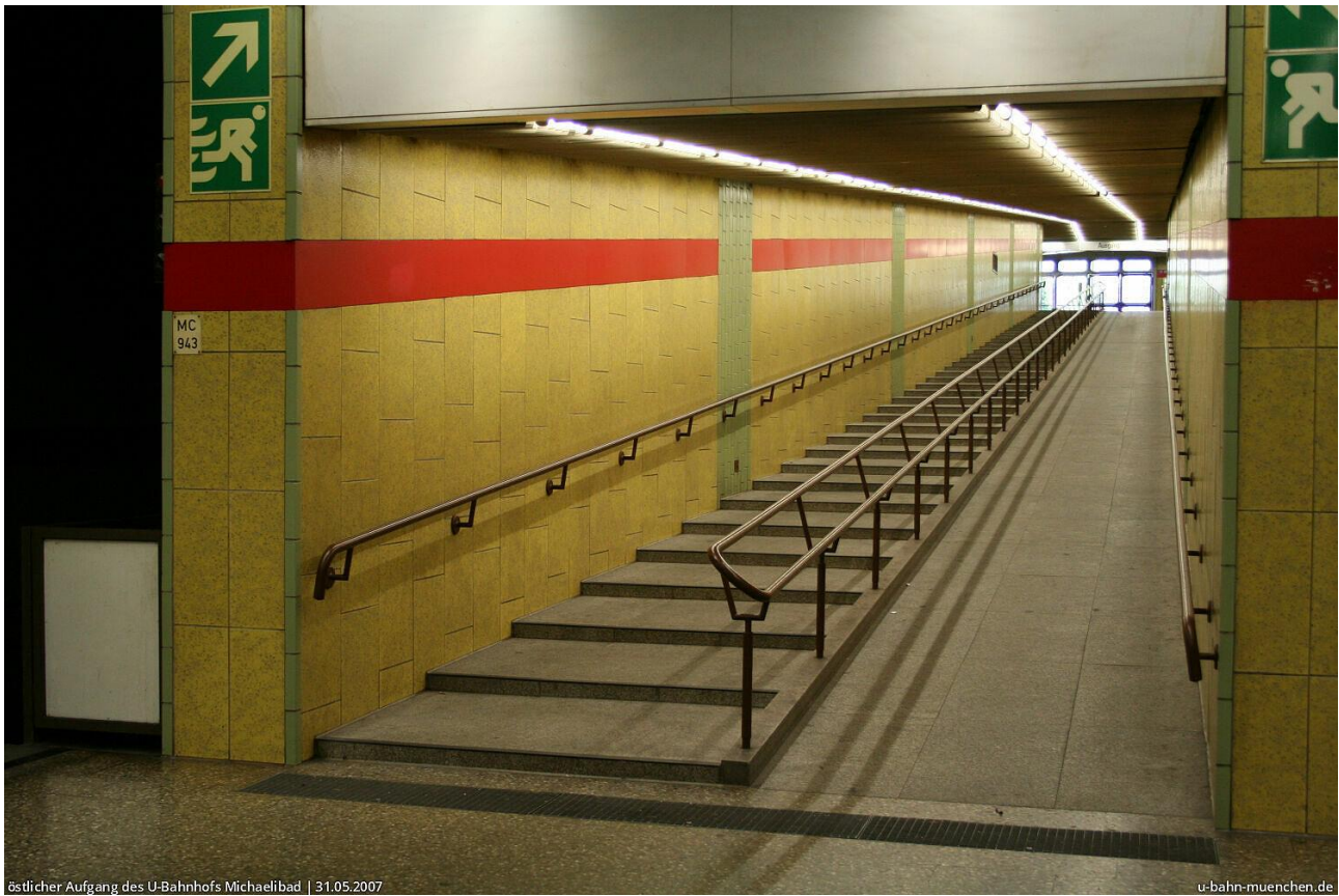
Abbildung 8: Zugangsrampe zum Bahnsteig Michaelibad [16] (Florian Schütz, u-bahn-muenchen.de)
