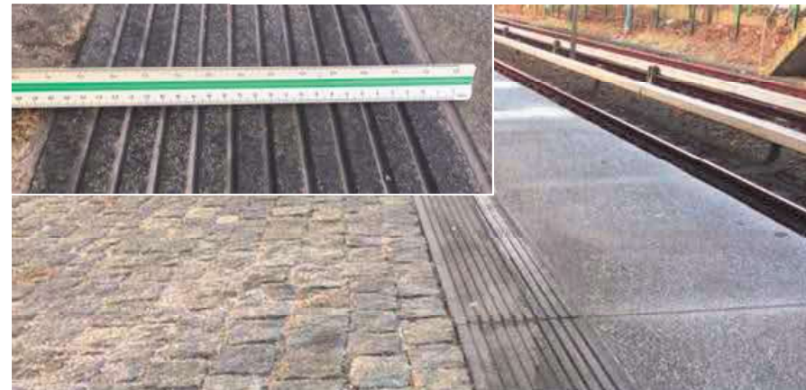
Eingebaute, vorab gefräste Rillensteine (Garching-Hochbrück)
