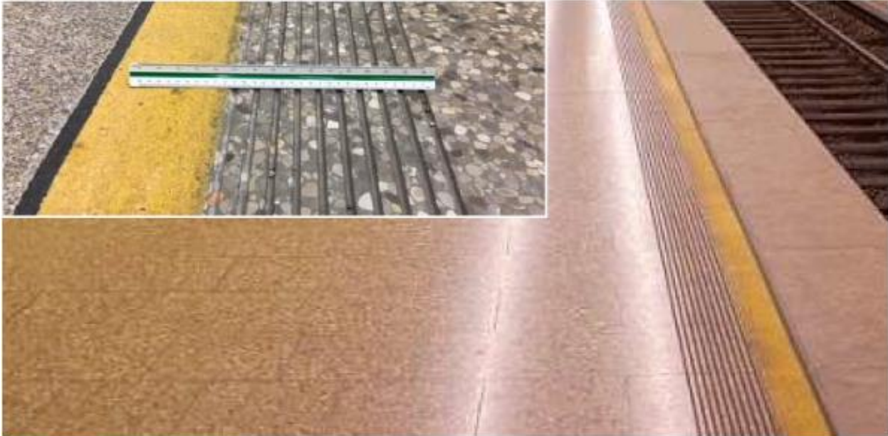
Abbildung 12: Taktiles Leitsystem im Bahnhof Sendlinger Tor mit eingefrästen Rillen [15]
