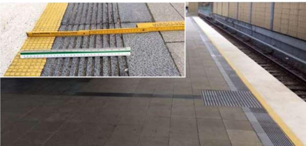
Abbildung 13: Taktiles Leitsystem im Bahnhof Studententadt nach DIN 32984 (alte Fassung) [15]
