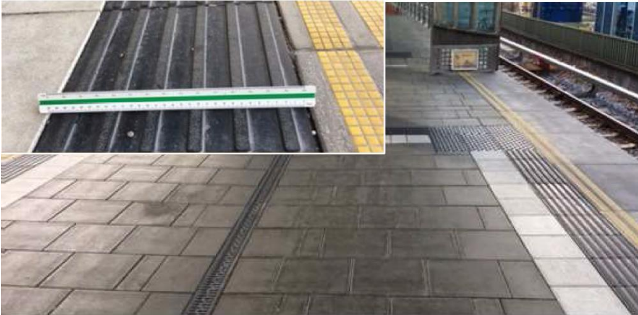
Abbildung 14: Taktiles Leitsystem gemäß DIN 32984 (2011) am U-Bahnhof Kieferngarten [15]
