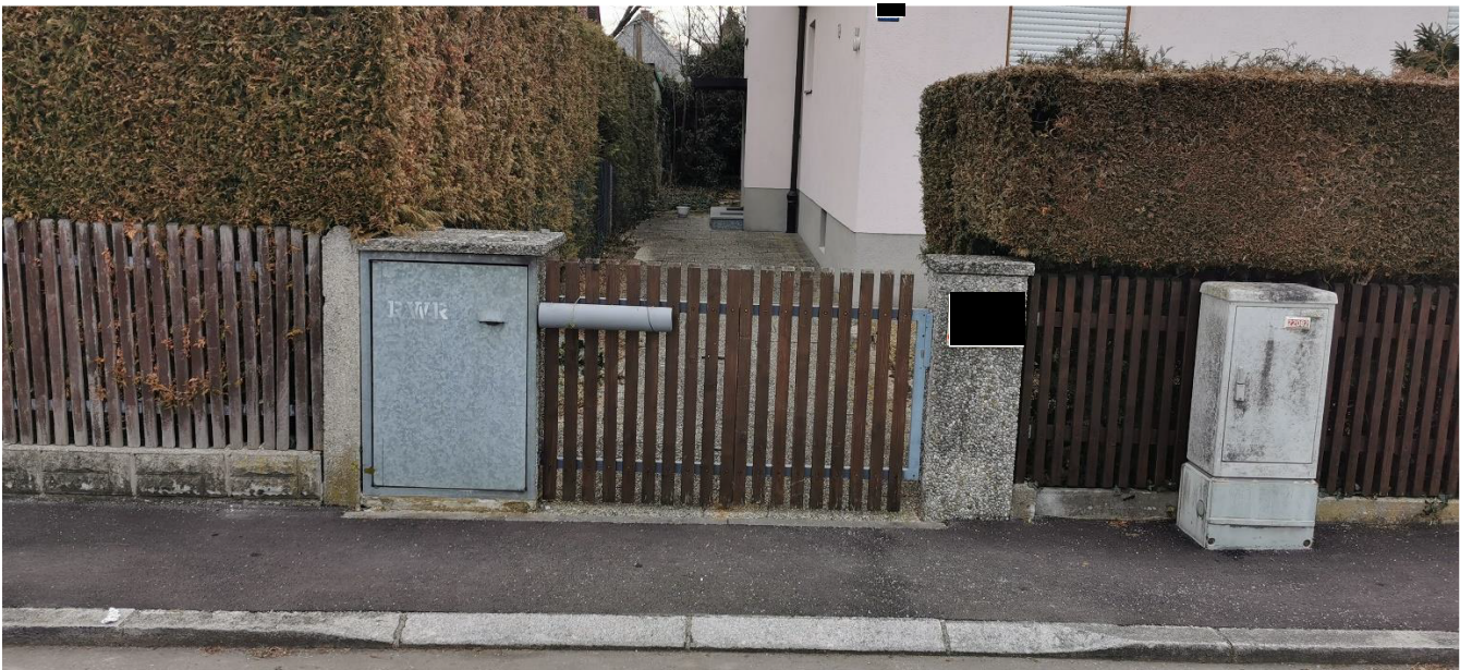
Hinter der Borsteinabsenkung befindet sich ein normaler Fußweg zum Hauseingang
