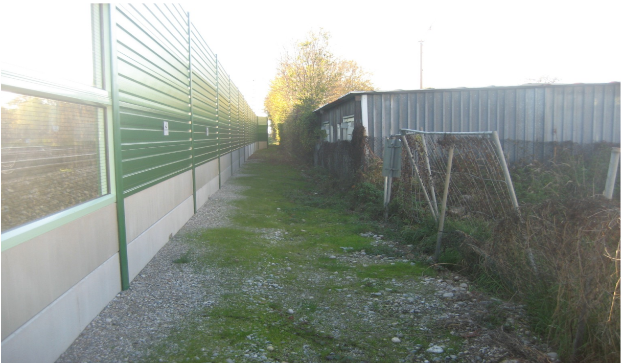
Foto 1: Potentieller Radweg-Korridor, 40 - 50 m lang, 3 m breit (Blick von Gronsdorf nach Westen)
