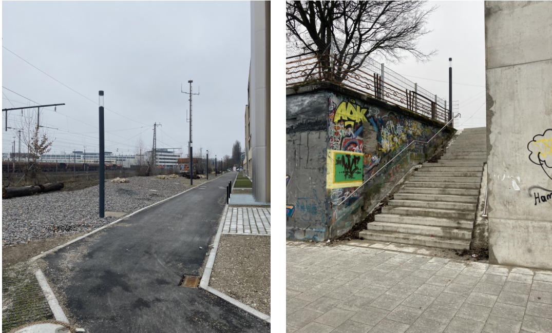
Abbildung 2 und 3: Feuerwehzufahrt mit Fuß- und Radweg hinter dem Neubau der Berufsfachschule und Treppenabgang zur Tumblingerstraße (Quelle: LHM / eigene Aufnahmen)
