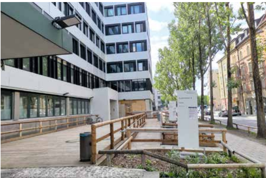
Besichtigung der Rampenanlage des KVR
