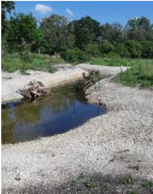
Renaturierung Bachlauf am Gut Obergrashof
