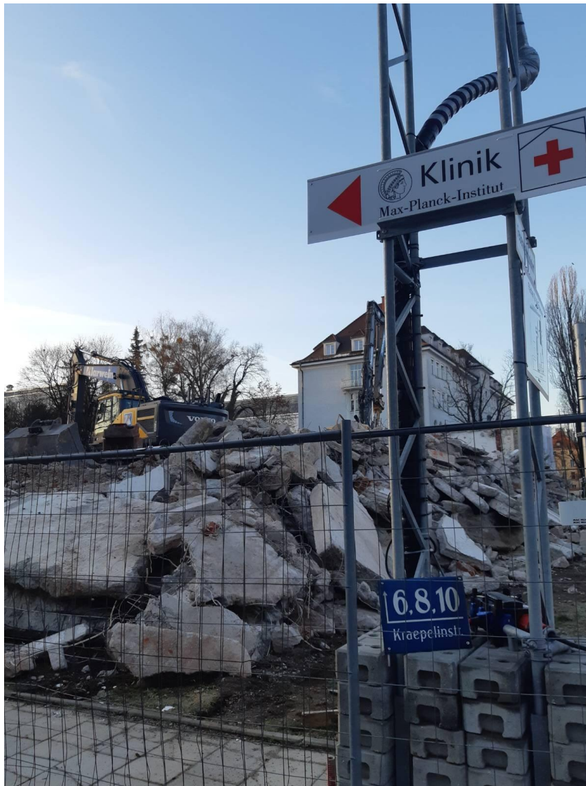
Abgebrochenen Wohnhaus der Kraepelinstraße 4, 4a, 4b (9. April, Foto privat)
