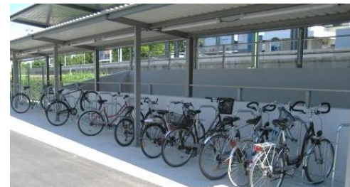
Überdachte und beleuchtete Fahrradabstellanlage
