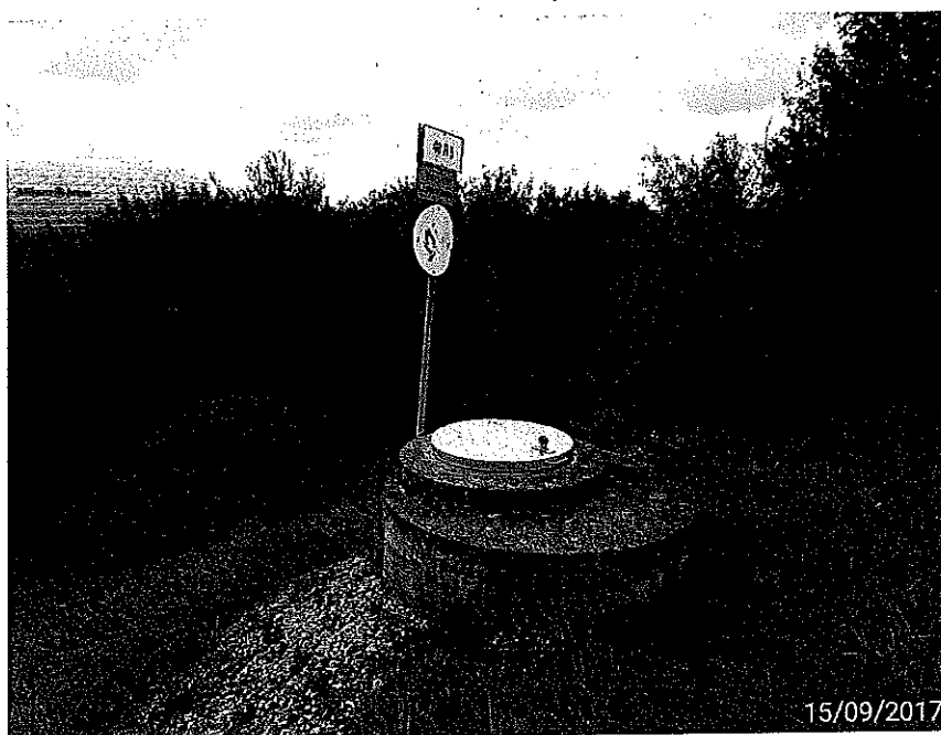
Beispiel für einen bestehenden Gaskollektor
