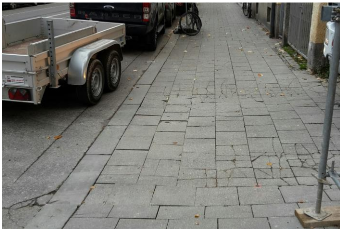
Abbildung 1: Beschädigte Zufahrt vor Barer Str. 77, trockener Zustand
