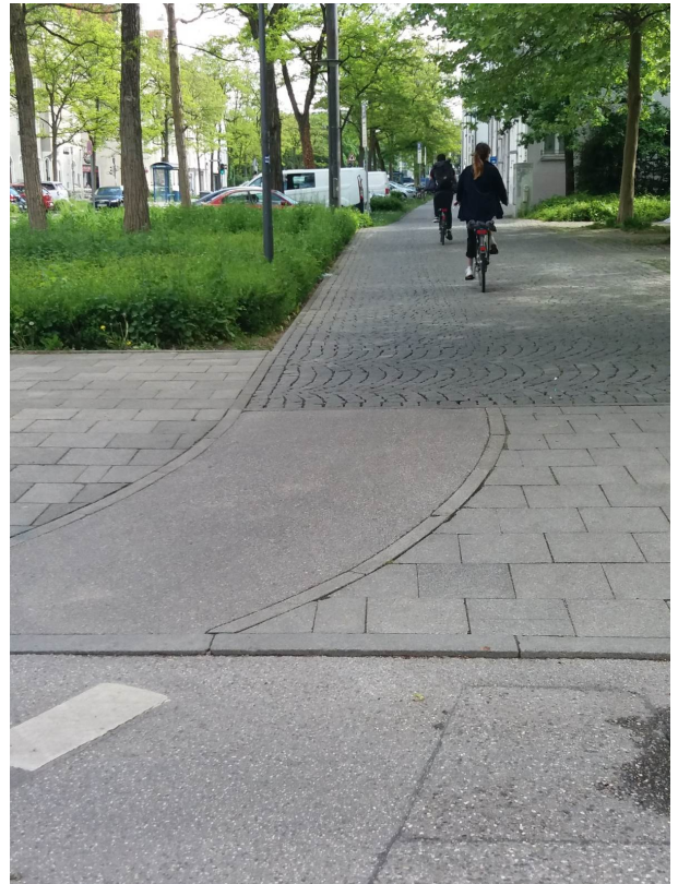
Radwegsituation Kreuzung Trappentreustraße/Gollierstraße, Fahrtrichtung nach Süden. Links: Fahrradweg am Ausgang der Busspur. Rechts: Überleitung Radweg in gemeinsamen Rad-/Fußweg. Keine optische Trennung der beiden Bereiche vorhanden.
