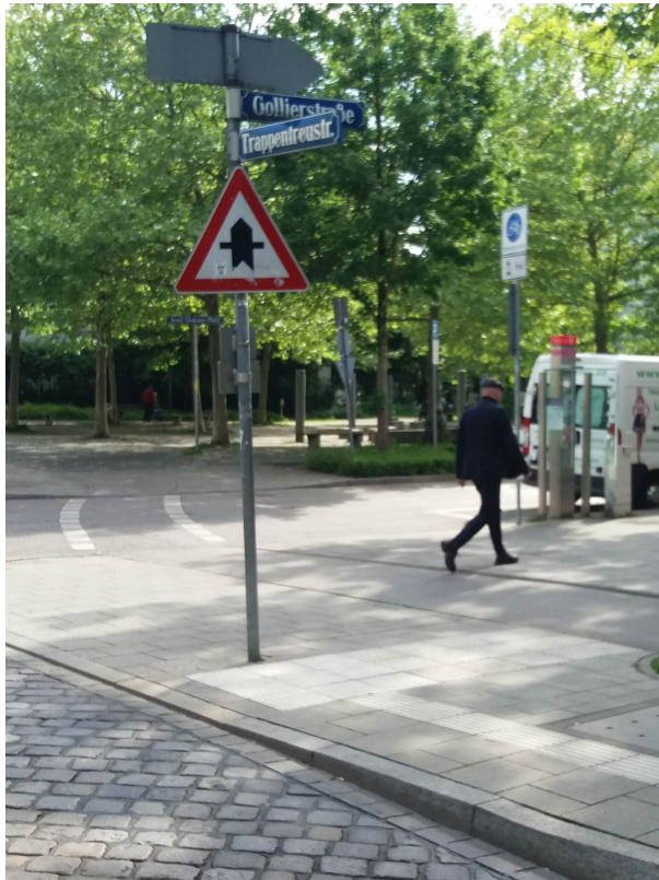
Radwegsituation Kreuzung Trappentreustraße/Gollierstraße, Fahrtrichtung nach Süden. Links: Fahrradweg am Ausgang der Busspur. Rechts: Überleitung Radweg in gemeinsamen Rad-/Fußweg. Keine optische Trennung der beiden Bereiche vorhanden.
