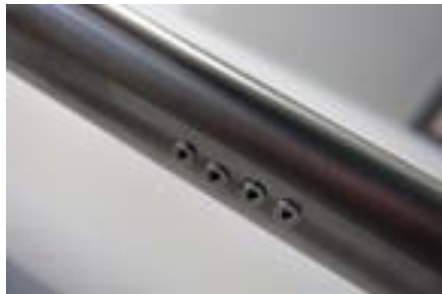
Beispiel: Taktile erfassbare Knöpfe an einem Handlauf, (Foto: Birgit Schimmel)
