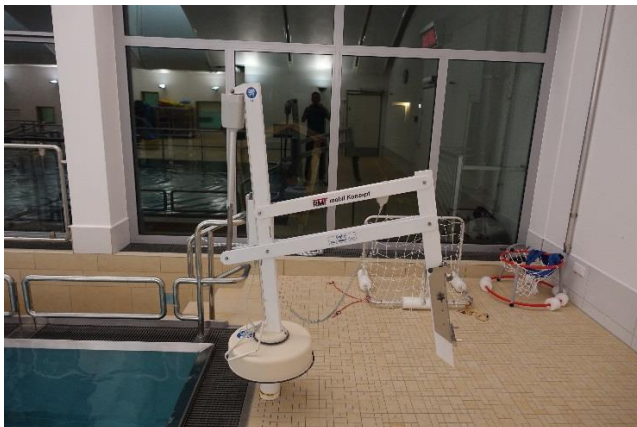
Beispiel: Lifter mit Einhängvorrichtung für Duschrollstuhl oder Liege, Ernst-Barlach-Schulen (Stiftung Pfennigparade), München (Foto: Birgit Schimmel)
