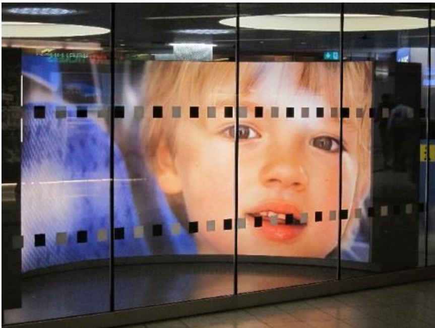
Beispiel für Sicherheitsmarkierungen an Glaswänden (Foto: Marienplatz Sperrengeschoß, München, Birgit Schimmel)
