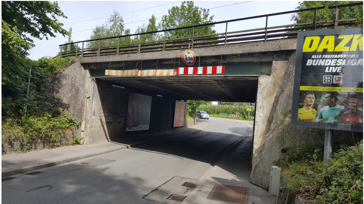
Bild: Sebastian Kriesel Blick von Norden, Limesstraße in die Unterführung
