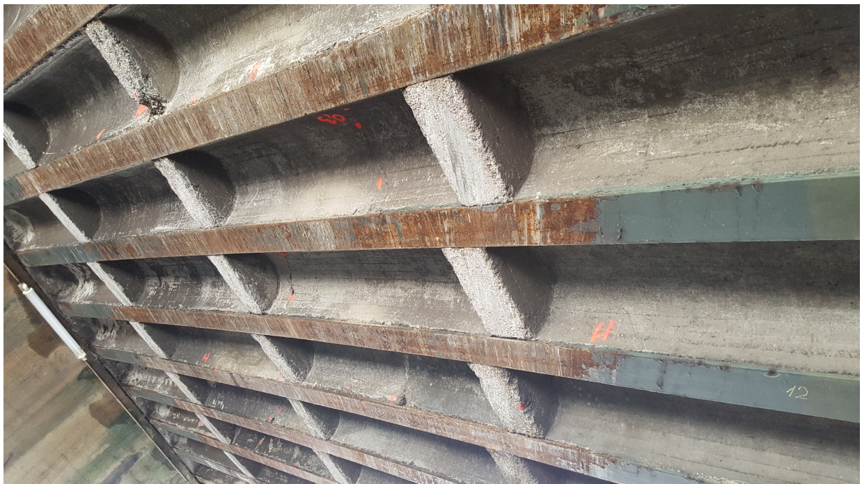
Bild: Sebastian Kriesel Blick in die Unterführung auf die Decke
