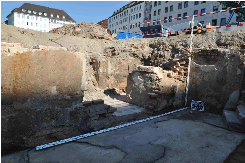
Kelleranlagen des ehemaligen Hotels Englischer Hof, später Stadtverwaltung, an der Diererstraße (Aufnahme ReVe, Büro für Archäologie Bamberg).
